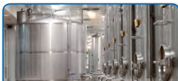
Tankreinigung tank cleaning
